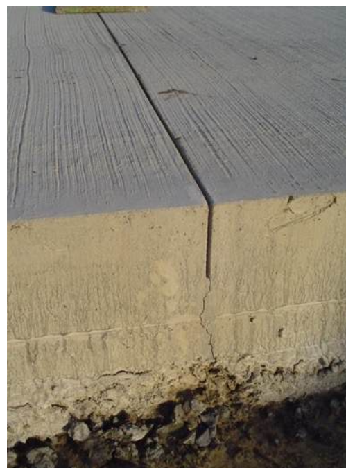
Getrokken beton met uitzetvoegen
