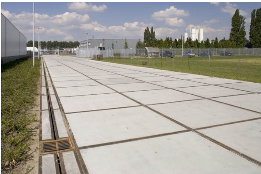
Stelconplaten met geïntegreerde afwatering
