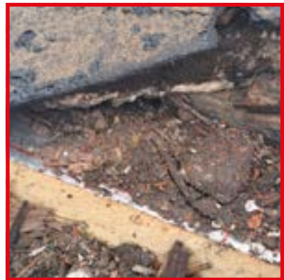
isolatie, schilfers en roofing
