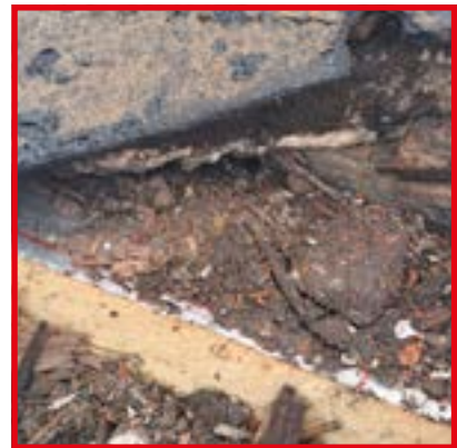
isolatie, schilfers en roofing
